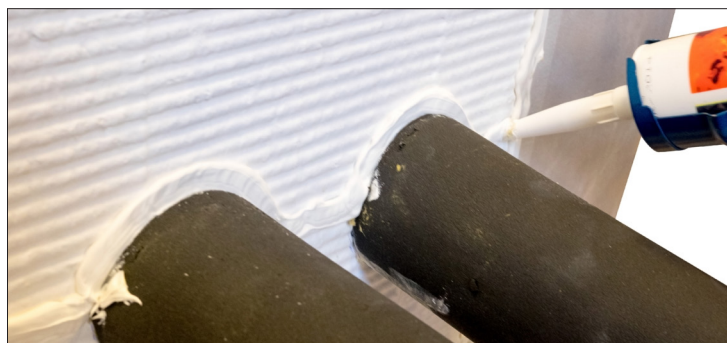
Fug om gennemføringen og i kanten af pladen, så der tætnes mellem brandplade og konstruktion.
