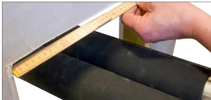
Opmål hullet og tilskær FireFree® B744 /B745 brandpladen. Brandpladen kan med fordel indeledes i flere stykker, for nemmere montage omkring rør.
