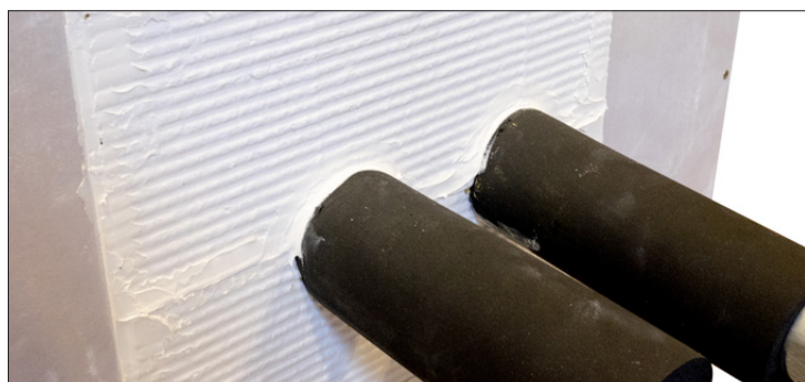
For en pæn og ensartet finish anbefaler vi, at der bruges malertape omkring hullet, før der fuges langs kanten af brandpladen. Flot finish kan evt. udføres med spatel.
