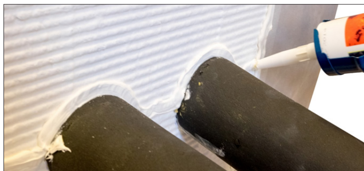
Fug om gennemføringen og i kanten af pladen, så der tætnes mellem brandplade og konstruktion.
