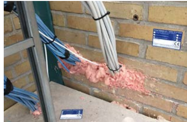
Ukorrekt udførte brandlukninger kan betyde store omkostninger og forsinkelser af byggeriet.
